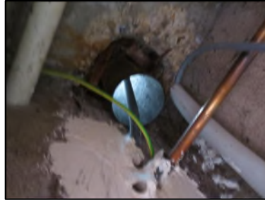
Photo N° 656 AMIANTE CIMENT -- GAINE TECHNIQUE GAZ 4 Conduits de fluide Ventilation haute (Fibres-ciment)
